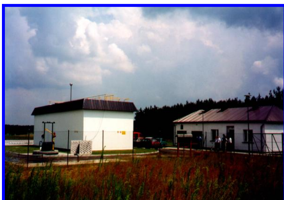
Oczyszczalnia ścieków BIO B 200 w Ostrówku pow. Wieluń o mocy wykorzystywanej 0,44 \text{ kW/m}^3 . Oczyszczalnia o minimalnej strefie oddziaływania na środowisko. Została wykonana w wersji wyniesionej jako jeden blok architektoniczny wraz ze stacją dmuchaw i pomieszczeniem technologicznym. Po prawej stronie widoczny budynek zaplecza socjalnego wraz z agregatorownią i
